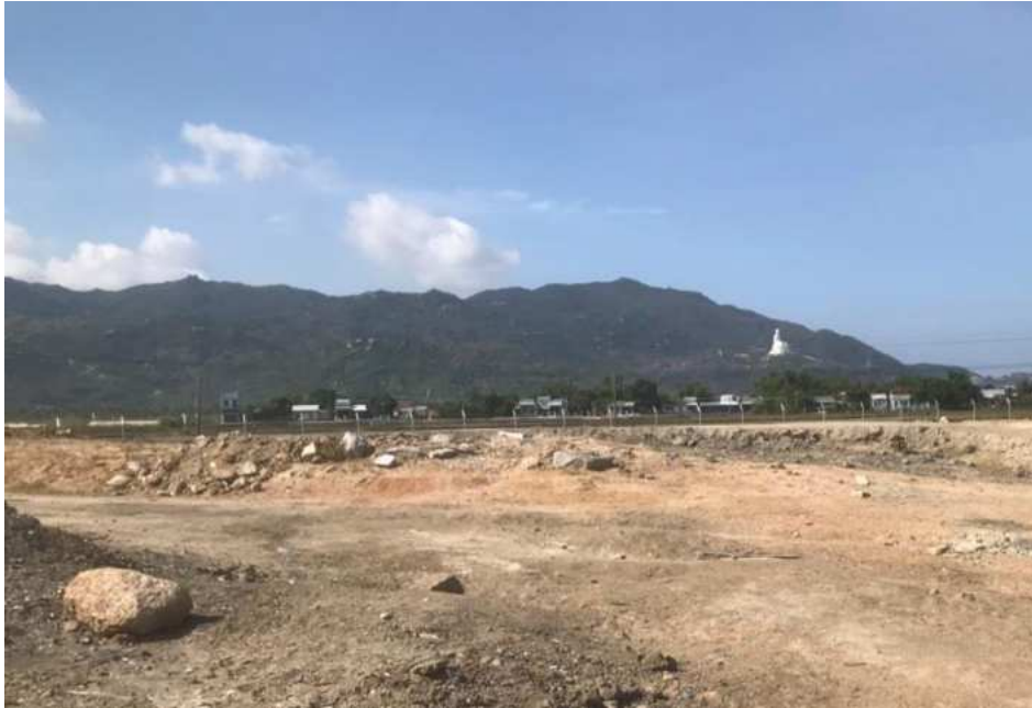
Hình 1.3 Hình ảnh hiện trạng khu đất xây dựng nhà máy nước Văn Mối
