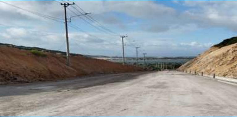
Mặt bằng thi công tuyến đường Nhơn Hội - Nhơn Hải (đoạn từ Bãi Rỗi đến Trạm bơm tăng áp Nhơn Hội)
