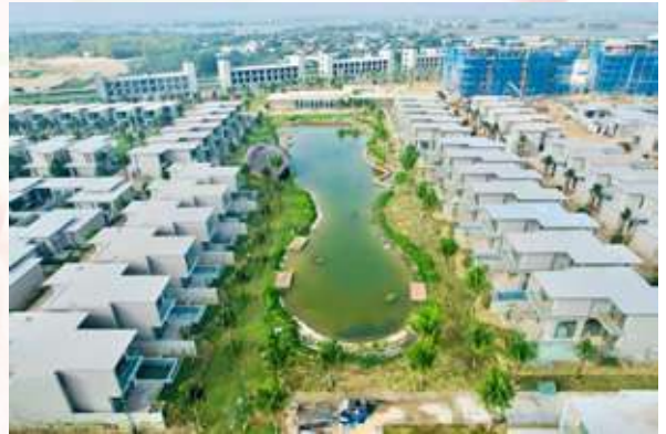
Toàn cảnh thi công Dự án Maia Quy Nhơn Beach Resort (gđ2)
