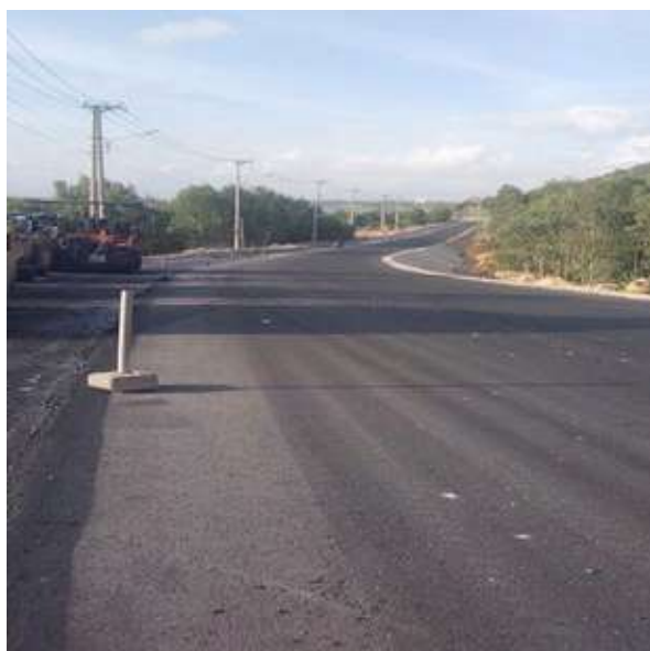
Dự án sửa chữa, nâng cấp tuyến đường Nhơn Hội - Nhơn Hải (đoạn từ Bãi Rôi đến Trạm bơm tăng áp Nhơn Hội)
