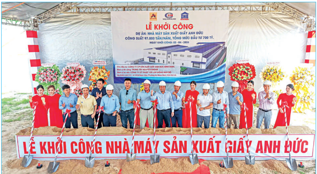
Khởi công dự án Nhà máy sản xuất giấy Anh Đức tại KCN Nhơn Hòa
