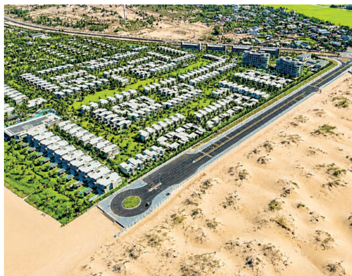
Tuyến đường nối từ nút T24 đường trực Khu kinh tế Nhơn Hội ra biển chụp từ flycam
