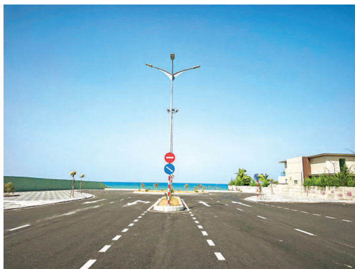
Tuyến đường nối từ nút T24 đường trục Khu kinh tế Nhơn Hội ra biển
